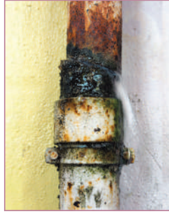
الشكل (20): طبقة من الصدأ المتكوّنة على أنبوب تصريف المياه العادمة.
