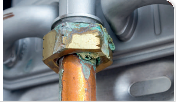
الشكل (19): تآكل فلز النحاس.
