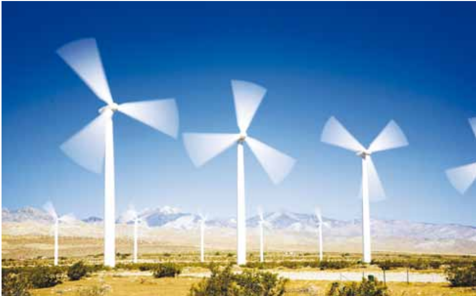
الشكل رقم (٢ - ٢٠): محطة توليد الطاقة الكهربائية باستخدام طاقة الرياح.
