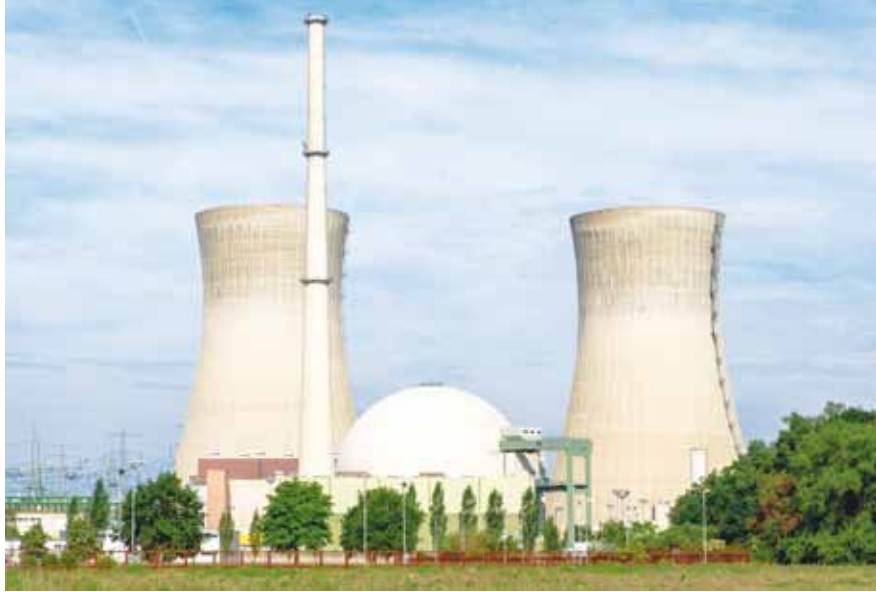
الشكل رقم (٢-١٨): محطة توليد الطاقة النووية.
