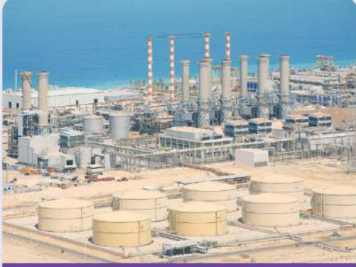
محطة تحلية المياه
