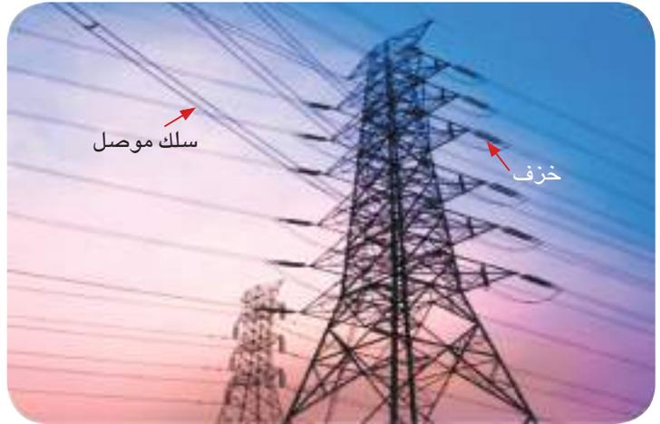
▲ تستخدم الأسلاك النحاسية لتوصيل الكهرباء إلى بيوتنا
