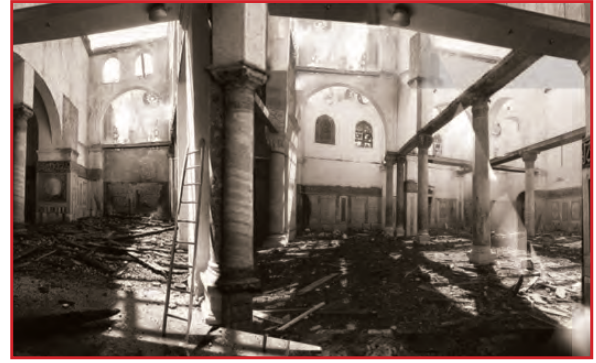
شكل ٤-١١ حريق المسجد الأقصى عام ١٣٨٩ هـ / ١٩٦٩ م
