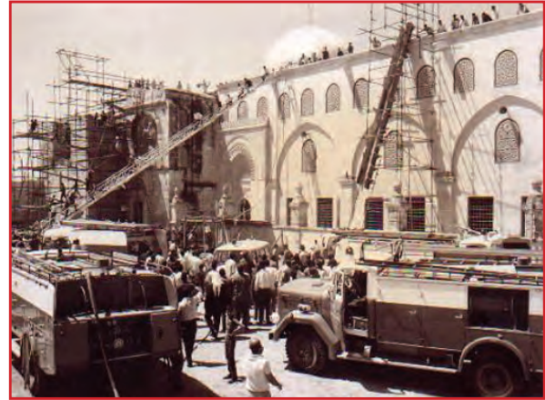
شكل ٤-١٢ حريق المسجد الأقصى عام ١٣٨٩ هـ / ١٩٦٩ م
