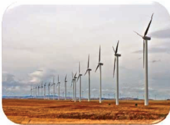
الصورة (١٨) توليد الكهرباء
