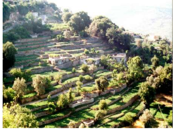
بناء المدرجات الجبلية
