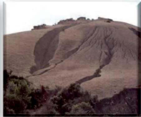
الصورة (27) انجراف التربة
