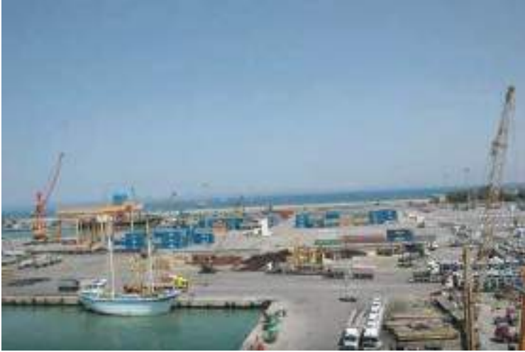
الصورة (١٢) ميناء اللاذقية
