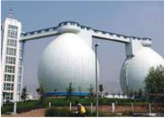
الصورة (٩) محطة لمعالجة مياه الصرف الصحي
