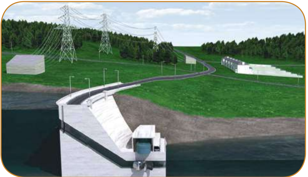
تستثمر طاقة المياه الموجودة خلف السدود في تشغيل المولدات الكهربائية لتعطينا الكهرباء
