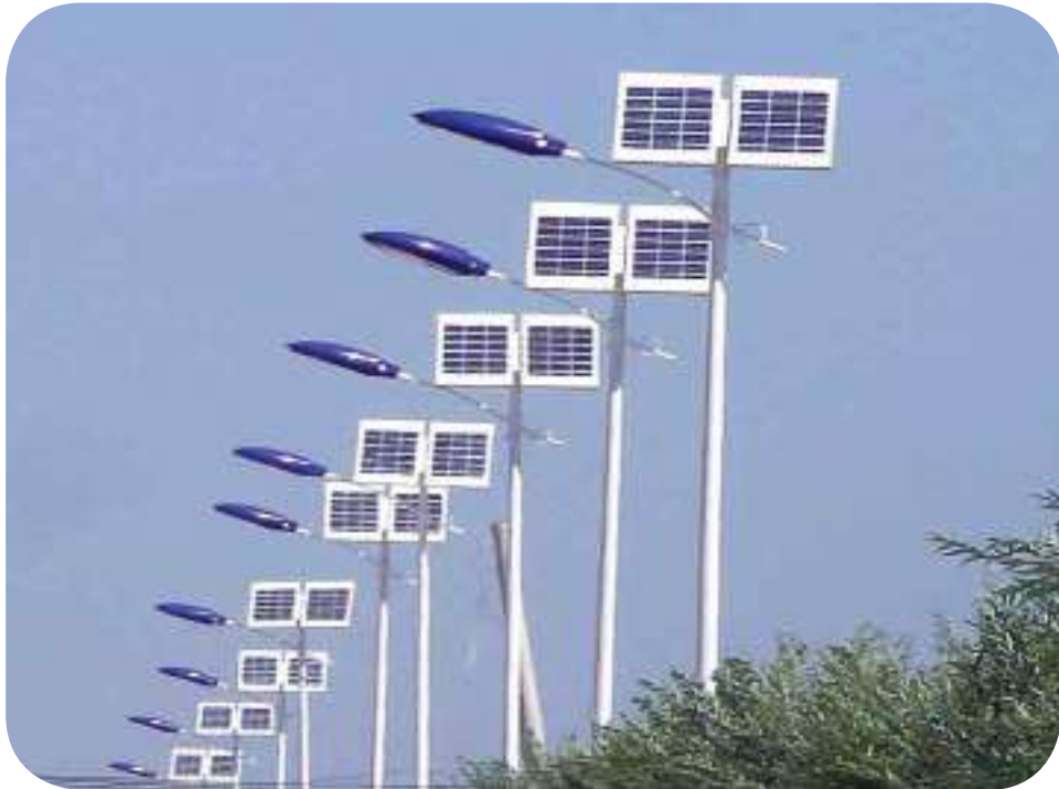
تستخدم الخلايا الشمسية في اضاءة الشوارع
