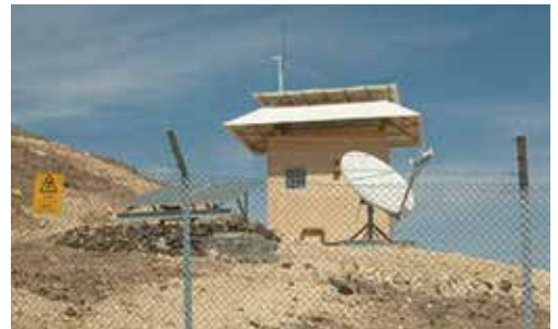
الشكل (١٤): محطة رصد زلزالي
