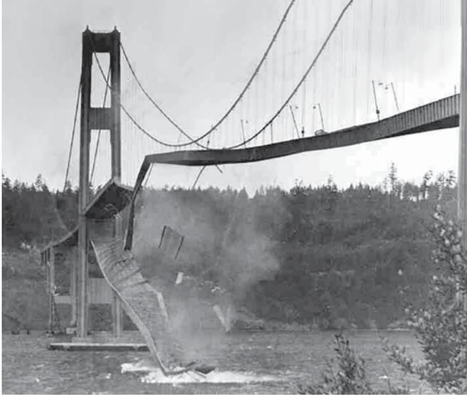
في الحسابان ألا تحدث ظاهرة الرنين عند حدوث الزلازل؛ فحدوث الرنين في المبنى عند اهتزازة يزيد من سعة الاهتزاز إلى درجة قد تؤدي إلى أضرار في المبنى أو انهياره.
