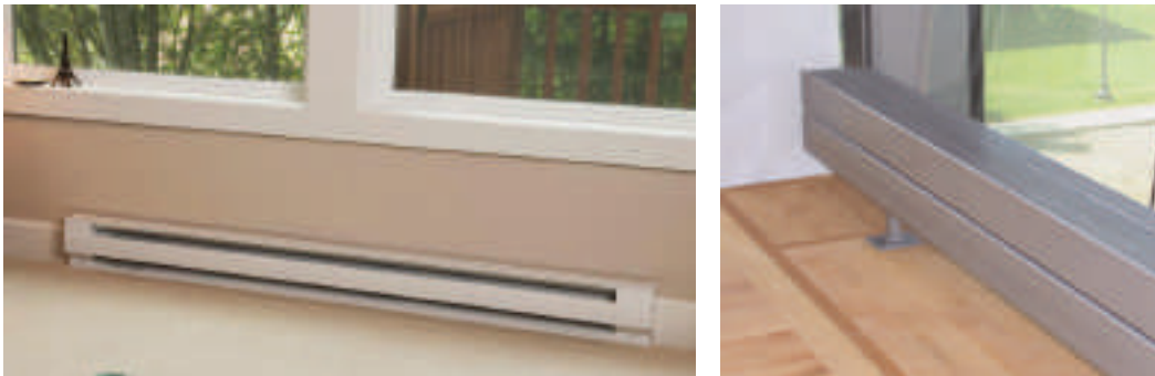
الشكل (9): بعض أنواع المُشِعَّات الأنبوبية المزعنة.
