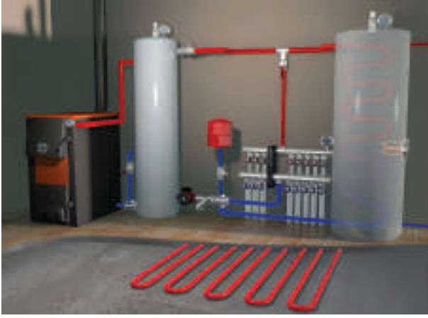
الشكل (22): خزان تمدد مغلق متصل بالشبكة.
