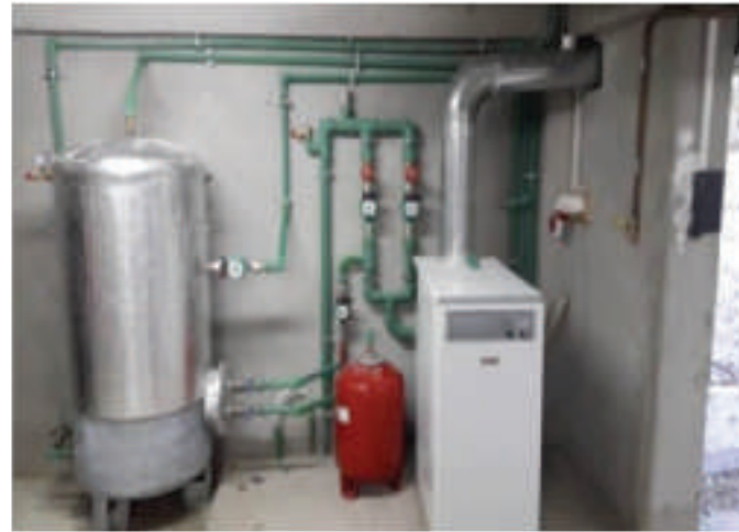
الشكل (8): نظام تدفئة بالمياه الساخنة يحتوي على مبادل حراري.
