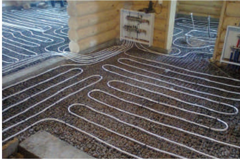
الشكل (14): نظام شبكة التدفئة تحت البلاط.
