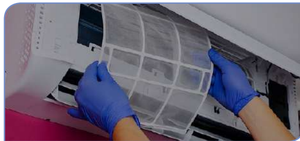
الشكل (2-20): فلتر هواء المكيف المجرأ.
