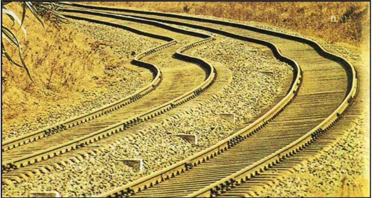
مستند ٨ اعوجاج السكك الحديدية الواقعة على بعد ١٦ كلم من مدينة الأصنام من جراء الزلزال الذي تعرّضت له
